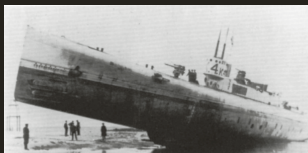
K4 efter att ha gått på grund under provturen. Båten har den ursprungliga låga bogen och kanon på fördäcket.
