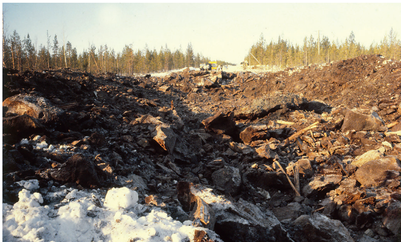
Vägsprängningsbild , vägbankssprängningar förbereddes främst på vägavsnitt där vägen var omgiven av myrmark. Sprängplatsen kompletterades med minering av omgivande kringgångsstråk där även platser med fyllnadsmateriel minerades.
