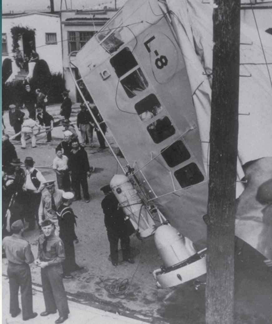
Bild 6. Gondolens vänstersida. Lägga märke till sjunkbomben som hänger kvar på denna sida.
