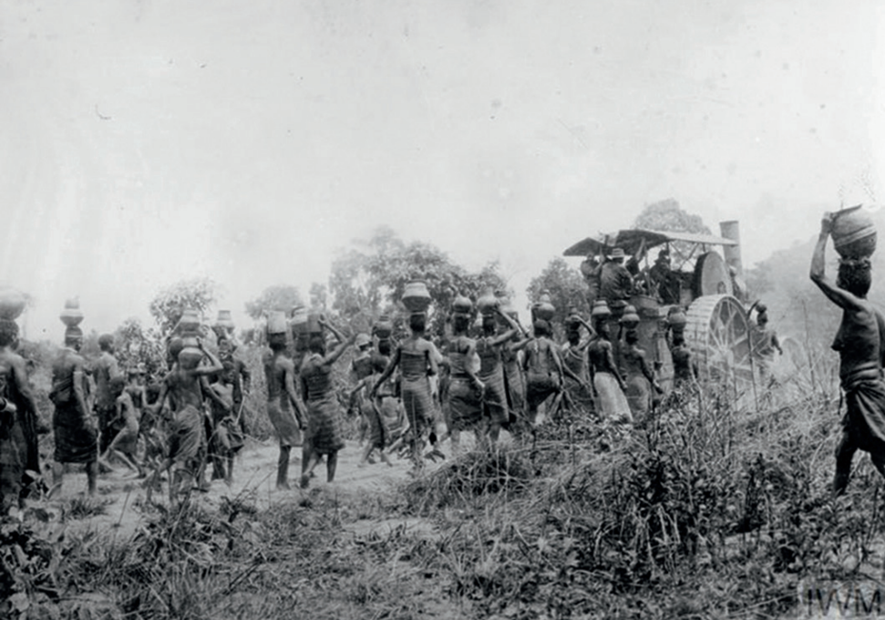
Bild 8. En av de två lokomobilerna. Kvinnorna i förgrunden bär troligen vatten för att fylla på i ångpannan. Det var stora problem att skaffa vatten till både folk, få och maskiner i den torra miombo-bushen.
