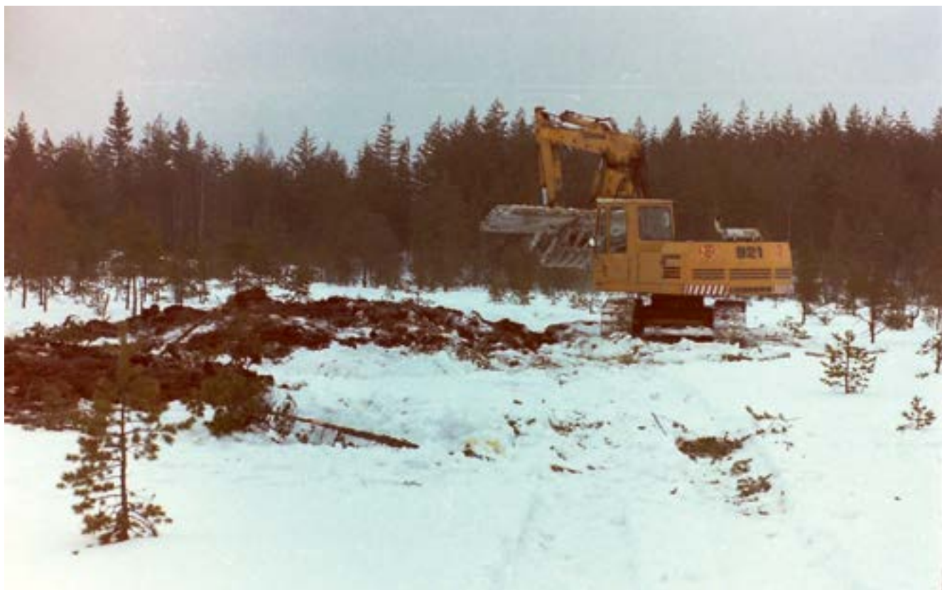
När väl grävmaskinen tog sig ut så användes virkesbäddar att larva ut på.
