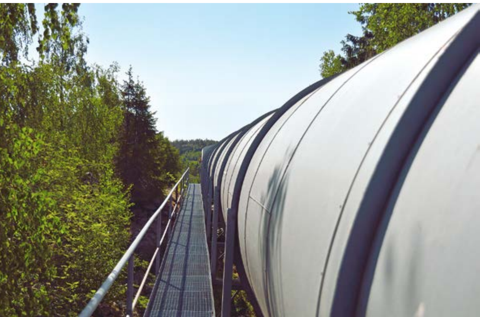
Laserbanan består bland annat av ett 65 meter långt rör som har en diameter på två meter
