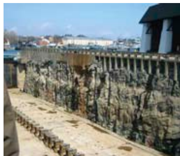
Polhemsdockan insprängd i berggrunden från 1724 konstruerades av Polhem och var då världsunik och kan användas än i dag.
