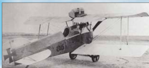
Prototypen 20.15. Man hade fortfarande inte tillgång till en synkroniseringsmekanism – babykorgen fick sitta kvar!
