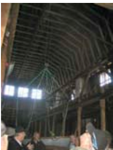
Wasaskjulet är en stapelbädd som klarade av linjeskepp med upp till 70 kanoners bestyckning. Stapelbädden är överbyggd av en ganska speciell huskonstruktion som fått sitt namn av att här byggdes linjeskeppet Wasa år 1778, ej att förväxla med Wasa i Stockholm.
