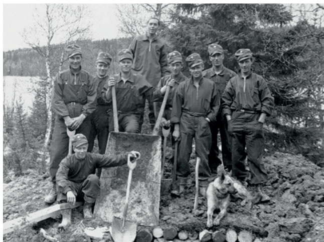
Befästningsarbeten vid Bodsjöedet i maj 1940. Foto: Ulf Malmsten.
